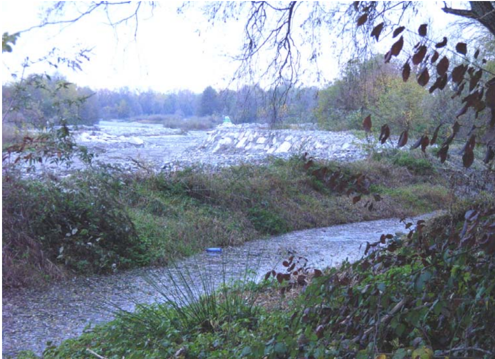
Foto 10: Derivazione del Canale del Molino dal T. Varaita. In primo piano si osserva il tratto parallelo all'alveo del Varaita. Sullo sfondo il tratto asportato nel 2008/2009 ed attualmente in corso di rifacimento con scogliera. La sottostante immagine areofotogrammetrica evidenzia l'opera di presa prima del suo danneggiamento.
