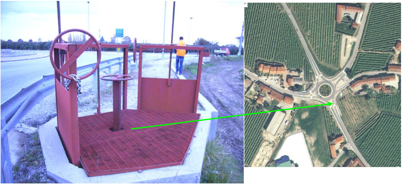
Foto 5: Paratoia di Falicetto (Verzuolo) che regola l'afflusso dell'acqua nel canale tombinato ( \varnothing 1000 , poi scatolare, Foto 6) lungo la S.P. n.137 che s'immette nel Canale Marchisa (Foto 6).
