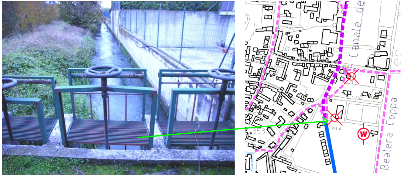
Foto 3: Canale del Molino. Paratoie che regolano l'immissione delle acque verso la "pesciera del Castello" (sinistra orografica), Canale del Molino (centro) e canale di Via Savigliano (destra orografica)
